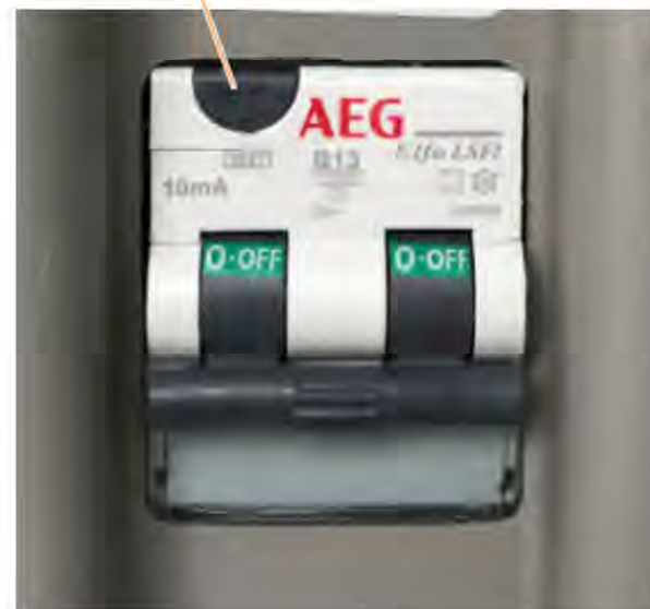
Disjoncteur différentiel (220 V) S59 avec contacteur pour contrôle du fonctionnement
